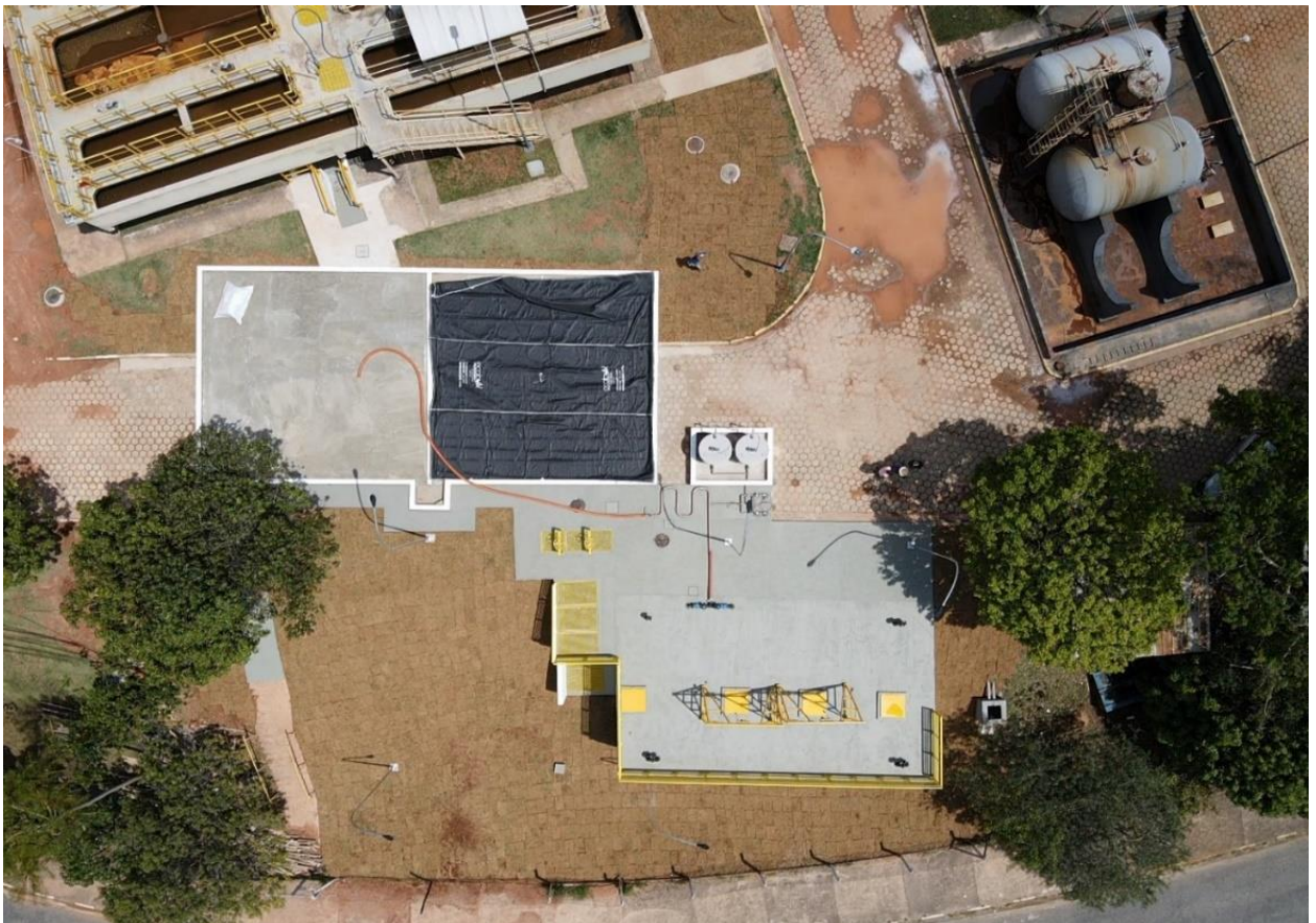
FIGURA 01: FOTO AÉREA DA IMPLANTAÇÃO PROVISÓRIA.
